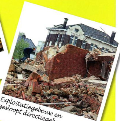
Oud directiegebouw uit 1943 onder de sloophamer
